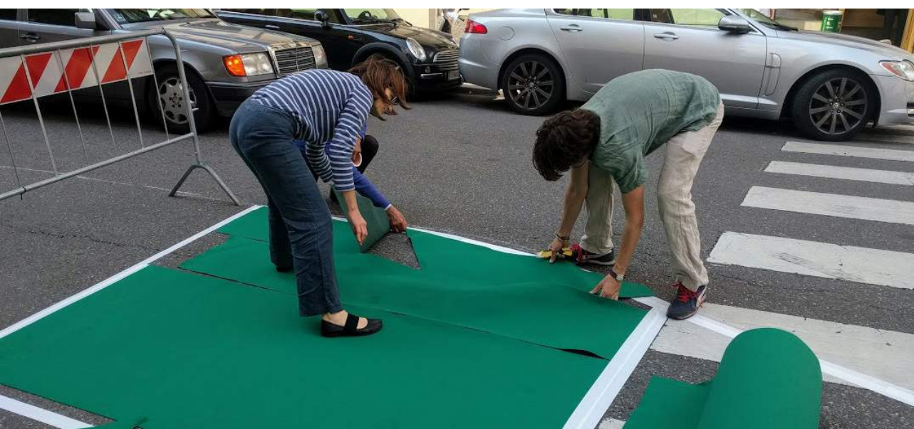
Il momento della posa della moquette verde per ridurre il calibro dell'attraversamento pedonale - Gabriele Sangalli
